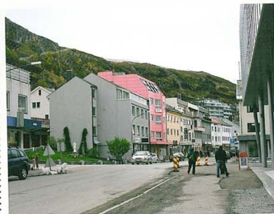
Hammerfest sentrum skal «totalrenoveres»
