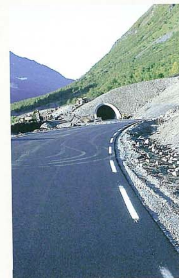
Nyttunnelen, med en av de 3 fangvollene i forgrunnen
