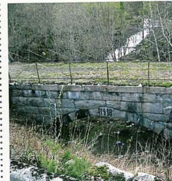
Brua med nytt løp
