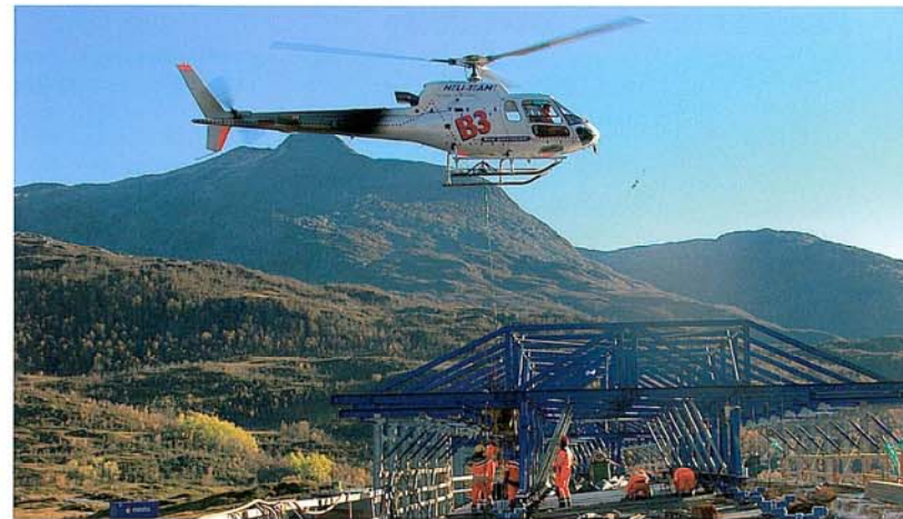
Nesten hver torsdag og fredag i sommer og høst har det blitt foretatt støping av brudekke med hjelp av helikopter. Imponerende presisjon av piloter.
