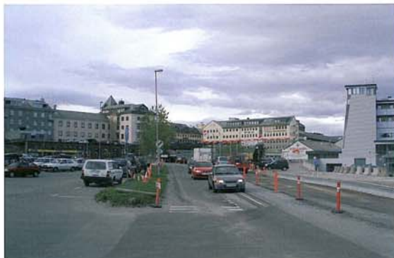
Krysset i jernbanevegen er åpent for trafikk i anleggsperioden men denne uka er biltrafikken dirigert opp på gang- og sykkelvegen
