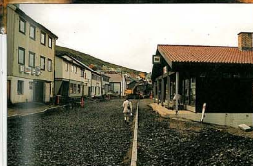
Under anleggsperioden var det tidvis dårlig framkommelighet for alle trafikkanter, noe som medførte omkjøringer og økt belastning for sidegatene. Holdningen blant de næringsdrivende har derimot vært positiv i hele anleggsperioden.
