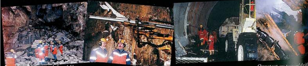
Tunnelgutta til Veidekke har fått god trening i å sette opp støpeskjold. Her er de i gang med å gjøre klar til en ny støpeprosess og dermed ferdig noen nye meter av Nordkapp-tunnelen.
