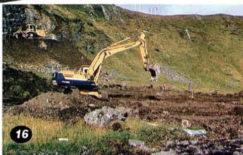
Bilde 15: Ut i august måned var det drift på alle parsellene i Fatima-prosjektet. Her er det forskjæringa for tunnelen fra Alf baklia til Honningsvåg som er påbegynt.
