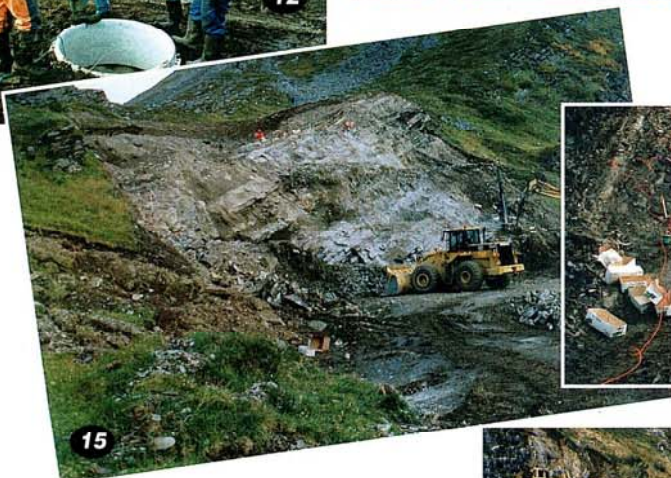
Bilde 15: Ut i august måned var det drift på alle parsellene i Fatima-prosjektet. Her er det forskjæringa for tunnelen fra Alf baklia til Honningsvåg som er påbegynt.
