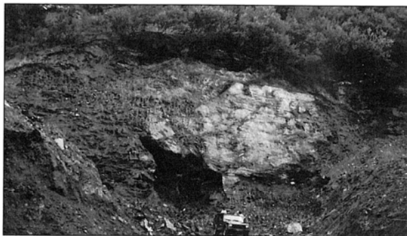
Påhugget til den undersjøiske tunnelen i Vesterpollen. Fjellet er rensket og gjort klart til arbeidet med selve tunnelen begynner til neste vår. (Foto: Kåre Furstrand)
