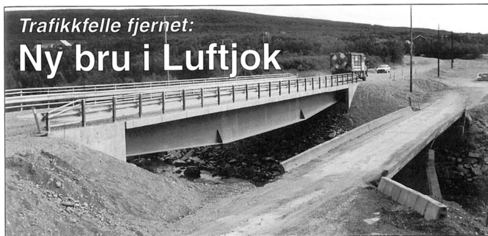
En stund kunne en se kvalitetsforskjellen mellom den nye og den gamle brua. Men i slutten av august ble gamlebrua (foran) tatt bort. Nå er det ingen ting som minner om den gangen Luftjok bru var noe de i Tana skremte ungene med.
