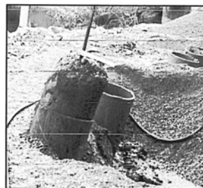
Leira på veg opp av pælene. 3-4 meter steg leirpølsene til værs før de la seg over på iden og brakk av. (Foto: Bjørnar Larsen)
