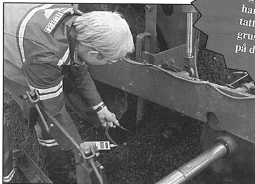
Enterprisene følges nøye opp. For alle kontrakter lages det kvalitetsplaner og det tas jevnlig prøver. På bildet er det Stein Gunleiksrud som tar prøver av asfalten ved Finnmark Asfalts dekklegging i Lakselv i sommer.
