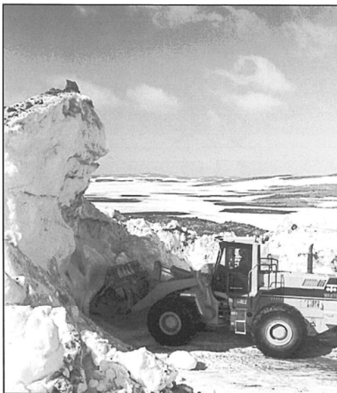
Det måtte fjernes store mengder snø før arbeidet med ny veglinje kunne begynne. I 14 dager ble det fraktet snø en veg og masse tilbake.
