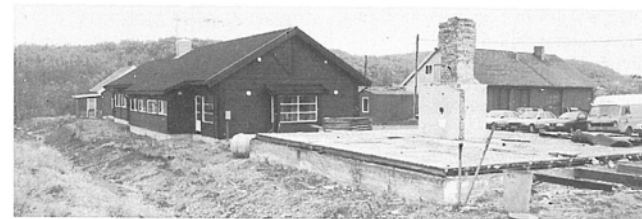
Den gamle vegstasjonen er i dag jevnet med jorden etter at sommerhjelpene fikk oppdraget. Det bød ikke på store problemer å ta vekk det råtne treverket.
