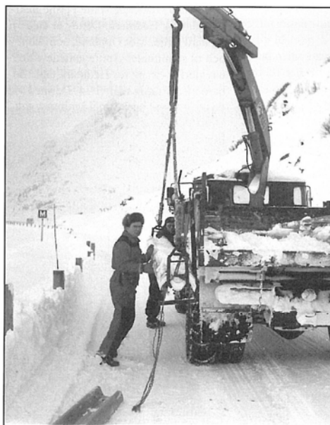
Skinneutleggeren i bruk i praksis. Utleggeren monteres på siden av lastebilen og gir god arbeidshøyde og en lettere arbeidssituasjon ved montering av rekkverksskinner.
