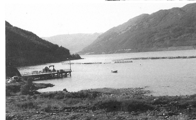
Fiskeoppdrettsanlegget ligger like nedenfor anleggsleiren. I bakgrunnen ser vi vegen der det skal sprenges bort 50.000 m 3 masse.
