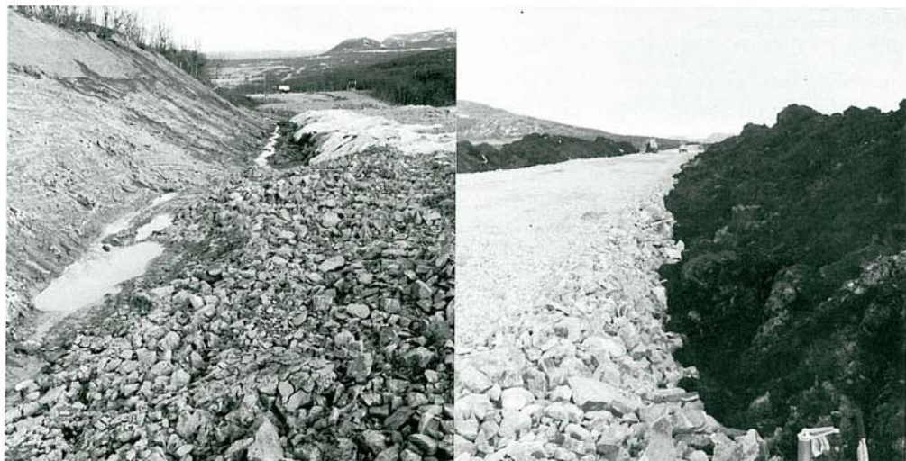
Fra denne bakken ble 80.000 kubikk leire fjernet og erstattet med knust fjell.
