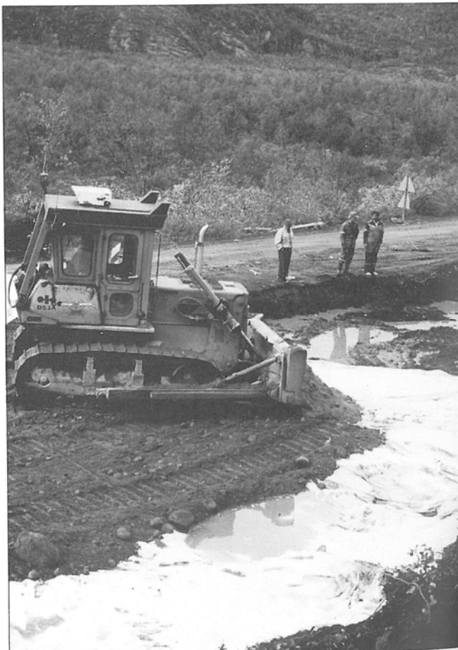
Etter at jordarmeringsduken er lagt ut kjøres det på masse og duken skal brettes og festes i kantene.
