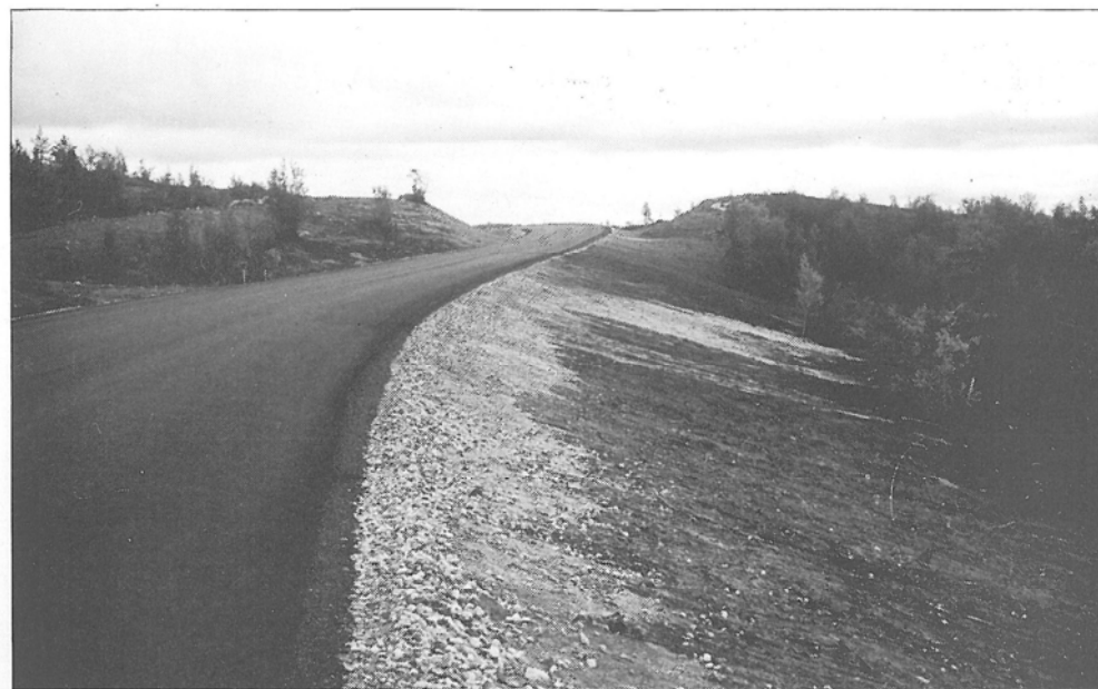
En lekker vegtrase blir resultatet av ombyggingsarbeidene på E6 mellom Neiden og Bugøyfjord.
