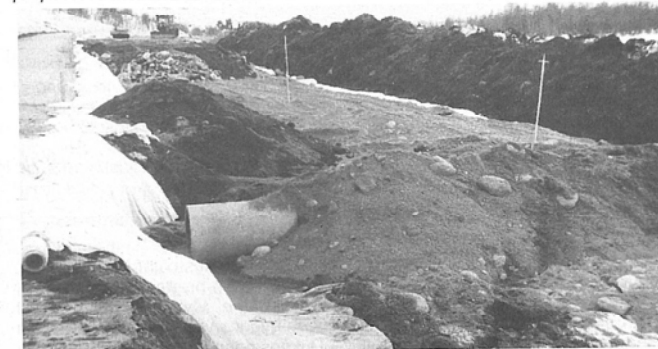
«Her finner du den verste kvikkleira i Norge». Anleggsleder Bjarne Gaski forklarer om fibermattene.
