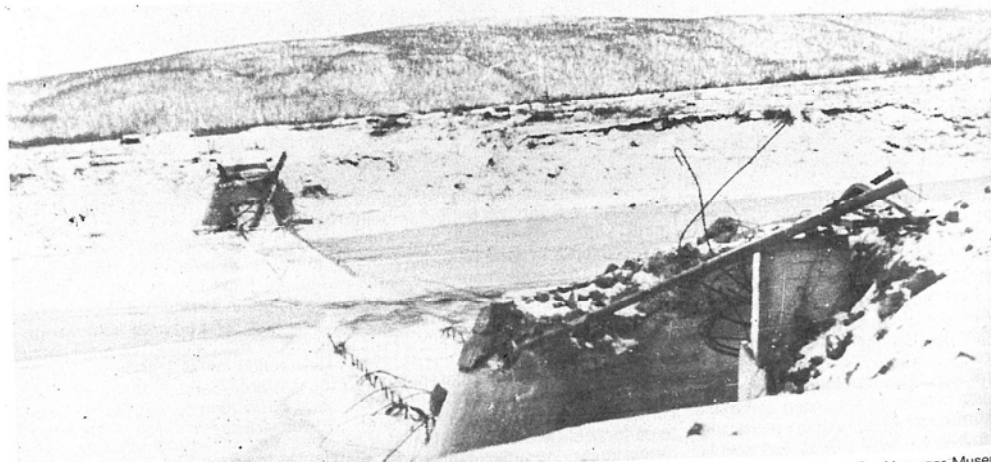
Tana bru etter sprengningen 1944. Gjenoppbygget i 1948.
