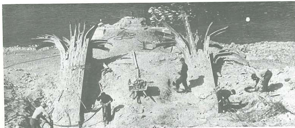
Nesten samtlige av bruene i fylket ble sprengt under tyskernes tilbaketrekning. Her gjenreisningsarbeid på Tana bru 1946. Kabelfestene i forgrunnen. Det arbeides med å meisle bort betongen.
