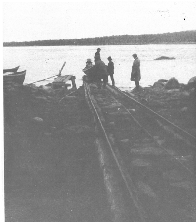
Trallbane i Pasvikdalen i Sør-Varanger ble bygget for transport av båter og gods forbi Melkefoss, Skogfoss, Kobbefoss, Jordanfoss, Hestefoss, Tangafoss samt over Langfjordeidet. Trallen med båt settes ut.
