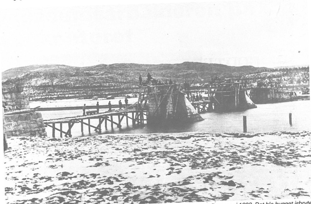
Alta bru ble bygget i årene 1891-1896. Her utbedres skadene på pillarene etter flommen i 1893. Det ble bygget isbryter på pillarene i 1894-95.
