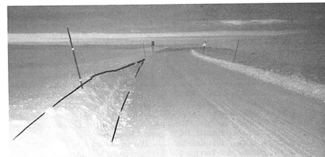
I forgrunnen, en begynnende snøfonn ved rekkverk. I bakgrunn snøforhold uten rekkverk.
