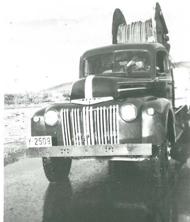
Y-2509 transporterer kablene til hengebroen over Storelva opp fra Kunes. (I førerhuset Rolf Simonsen).
