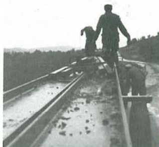
Det var ofte svært lite å gå på ved passering av nedkjøringer til provisoriske broer. Her ved en sjekk av surringene i tilfelle vegen gir etter.
