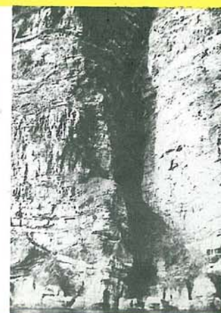
Ca. 20 meter dyp sprekk.
