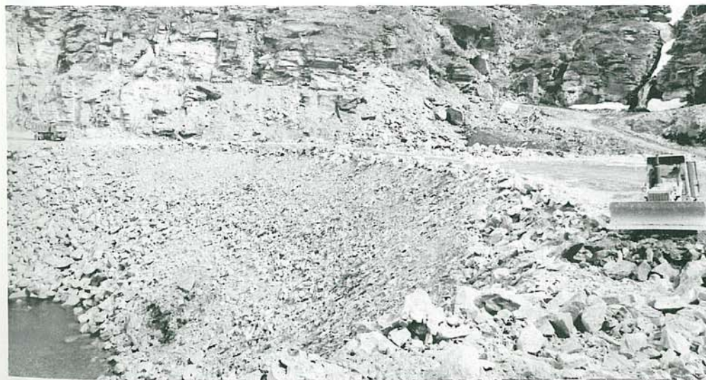
Dette er Finnmarks største fylling med 60.000 kubikk masse som fyller opp hele Lillevika ved Bakfjord. Mengden tilsvaret som ble sprengt ut i en salva.
