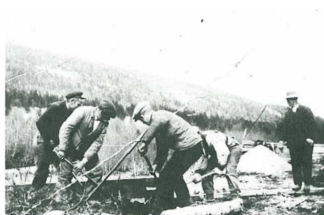
Fra et bruanlegg på Kautokeinovegen i begynnelsen av 30-åra.
