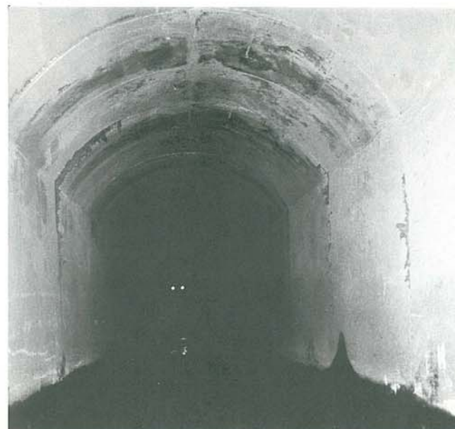
Det ser mørkt og trist ut i tunnelen i dag, men den skal bli både lys og sikker når tiden er inne. Her blir det god opplysning og avluftning slik at trafikantene kan ferdes trygt forbi det som før var et livsfarlig rasområde vinterstid.
