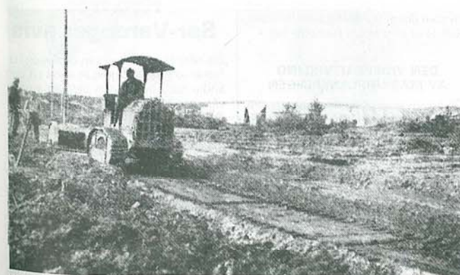
Planering i godt terreng med traktor og rullskrape.
