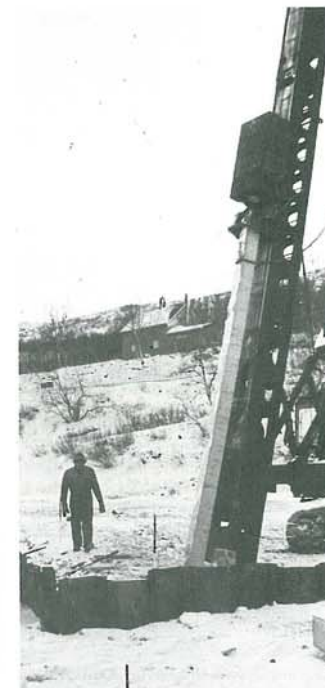
Det er ikke småtterier av peler som tvinges ned i bakken. Grunnforholdene var dessverre ikke helt slik som forutsatt, og det skapte litt problemer.
