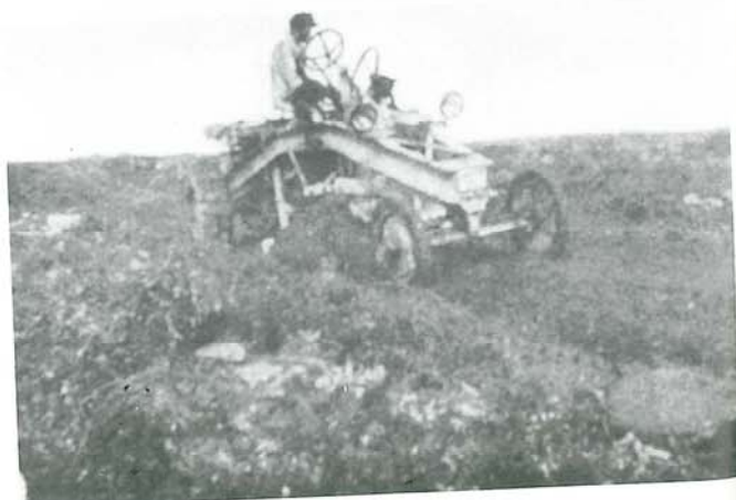
Veghøvel i arbeid
