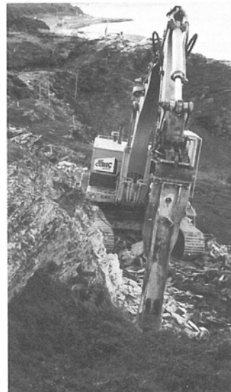
Gravemaskin med slaghammer nyttes til å lage anleggsveg slik at man kan komme fram i linjen med borerigg og andre maskiner. Man ser resultatet i bakgrunnen. Slaghammeren som er en Motabert 1100 er i dette tilfelle montert på en Cat 225 gravemaskin som blir kjørt av Jan Hansen fra Alta.
