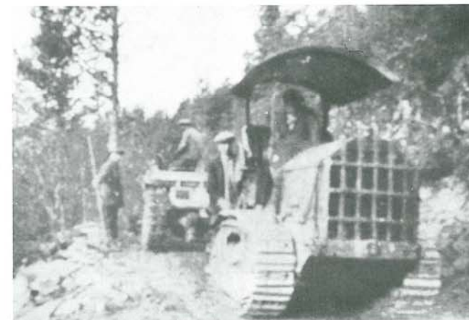
Traktor og veghøvel på veg oppover en fjellside. Stigning 1:10
