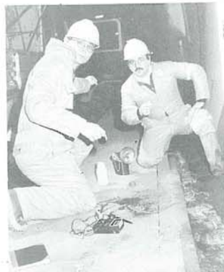
Her tas det prøver av vann og bakterier ved platehvelvet inne i tunnelen. Fra venstre: Trond Skotvold fra Asplan Trondheim A/S og Svein Roska fra Statens vegvesen Finnmark.
