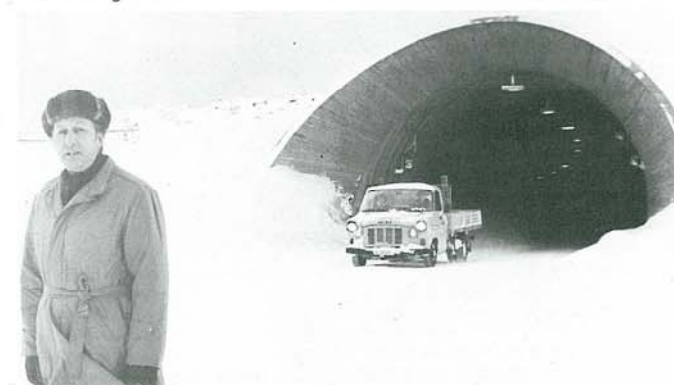
Ordfører Tor Kofoed ser lyst på tilværelsen etter at tunnelen kom, og kommunen er nå i ferd med å utnytte den muligheten fastlandsforbindelsen har gitt Vardø.
