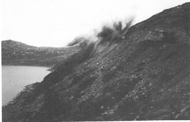
Dette er en salve som blir skutt hvor det blir gjennomslag i en sideskjæring som vi mener er den vanskeligste forsering av fjellpartiet mellom Snøfjord og Bakfjord.
