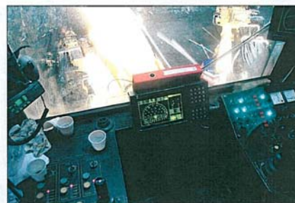
Det brukes en svært avansert borerigg i Stallogargotunnelen. Fra førerhuset har operatøren kontrollert med hele prosessen.
