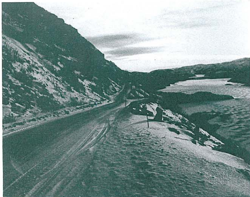
Vegen forbi Hauksjøen er en beryktet strekning. Fra ura på øversiden raser det hvert år stein ned i vegbanen, og fra den smale vegen går terrenget bratt ned i vannet.
