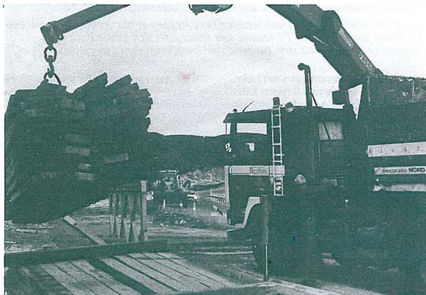
Her gjøres det siste arbeidet med den nye Reppen bru. Den midlertidige omkjøringsbrua demonteres og kjøres bort. I bakgrunnen pågår den siste oppussingen av vegskråningene.
