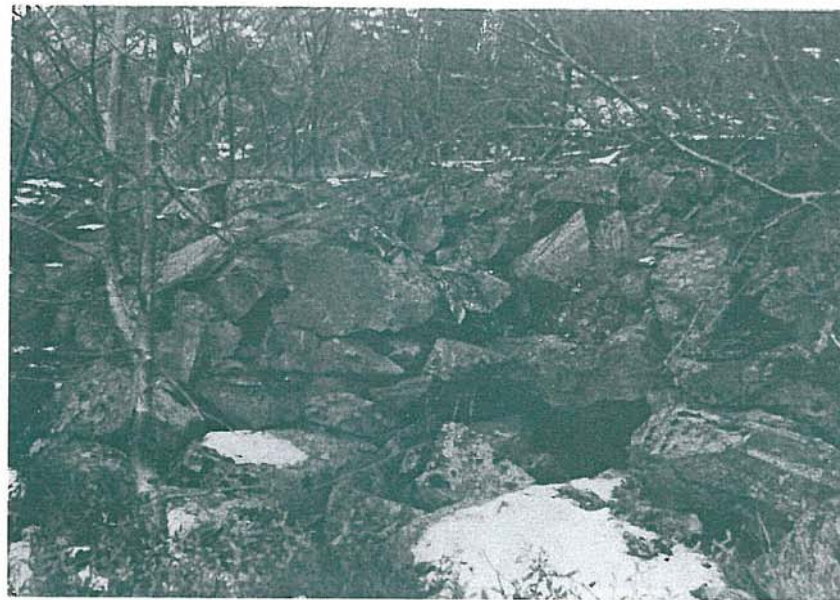
Vegen er tydelig bygget med tanke på at den skulle tåle alt av datidens tungtrafikk og meningen var nok at den skulle tjene vegfarende i mange, mange år. Men så ble den altså ikke tatt i bruk i det hele tatt. Stikkrenna vi ser er en såkalt 60-renne. Altså med størrelse 60 × 60 cm, som gjerne ble finere laget enn denne.
