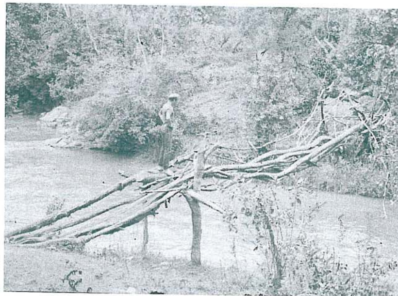
Brubygging (utført av masai'er). Ville vel neppe tilfredsstilt innbyggerne i Havøysund.
