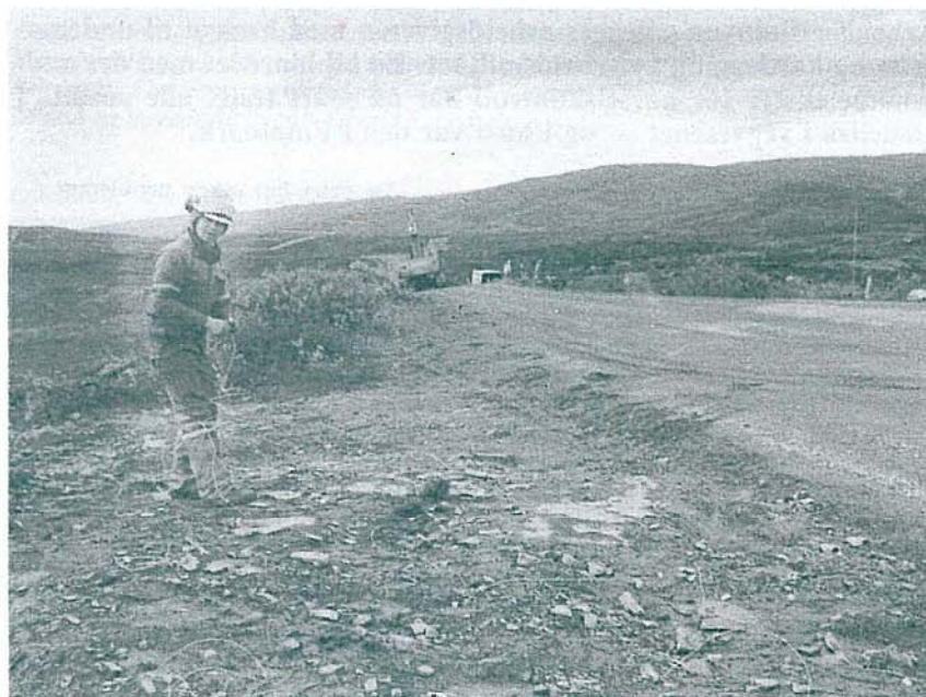
Arbeidet innbefattet også fjellsprengning. Her er det Nils Larsen som gjør klar til skyting i en sving ikke langt fra Estur.
