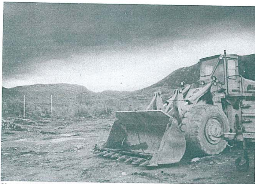
Vegvesenet er klar til å starte opp arbeidet fra Bekkarfjord neste år. Bildet er tatt fra anleggsleiren i Bekkarfjord og den vedtatte traseen går midt på bildet i bakgrunnen.
