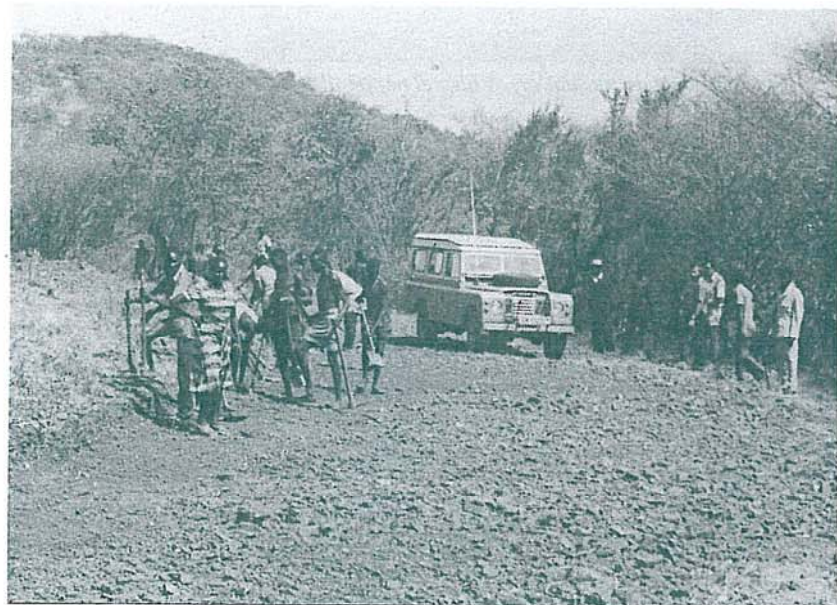
Vegbygging med hakke og spade. Primitivt, kanskje, men det skaffer arbeid og veg til mange.
