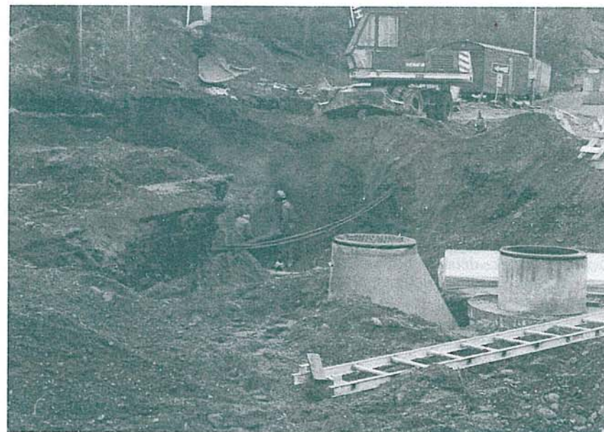
Som den reneste undergrunnsbevegelse måtte vegvesenets folk boltre seg under vegbanen. Det ble store krater, men det var nødvendig for å få arbeidet forskriftsmessig gjort.
