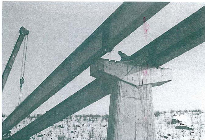
Bjelkene skal også festes godt i pilarene.
