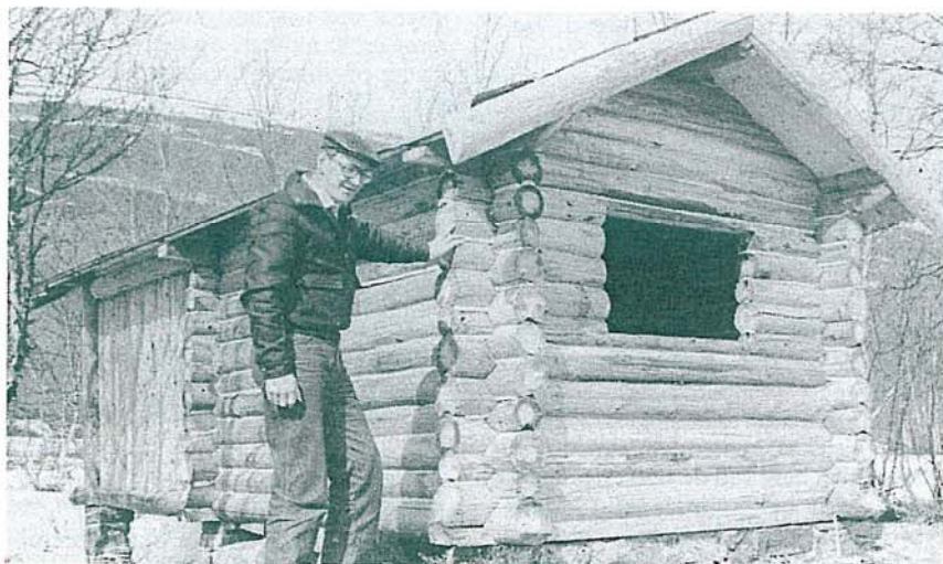
Den første tømmerhytta som Inge Fred har laftet og satt opp. Tømmeret er 50 år gamle telefonstolper fra en linje på vidda. Teknikken har han lært seg i Rauland i Telemark. Hytta står på Tanaelvas bredd, og var ikke helt ferdig da Refleksen var på besøk.
