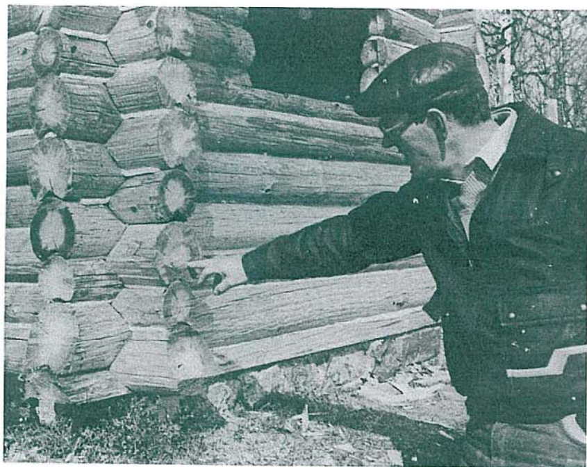
Det er god kvalitet på 50 år gamle telefonstolper, konstaterer Inge Fred Dervo. Og de er godt brukbare til tømmerhytteproduksjon. (Foto: Bjarne Langseth)
