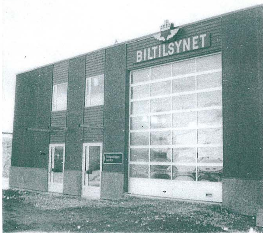
Biltilsynets stasjon på Hesseng. Tilfredsstillende lokale og arbeidsforhold.
