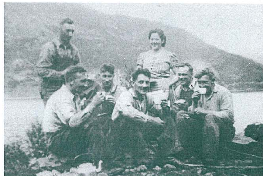
Bildet er fra anleggsarbeidet på rv. 6 (daværende rv. 50) i Langfjord i Alta i 1937. Anleggsarbeidet i Langfjord var et av de siste områdene som ble ferdig på rv. 6 i Finnmark. Høsten 1940 ble strekningen ferdig.
