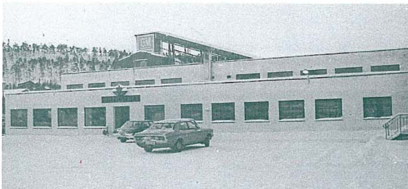
Biltilsynsstasjonen i Alta, som ligger på Elvebakken. Hallen er den bakerste delen av bygget.
