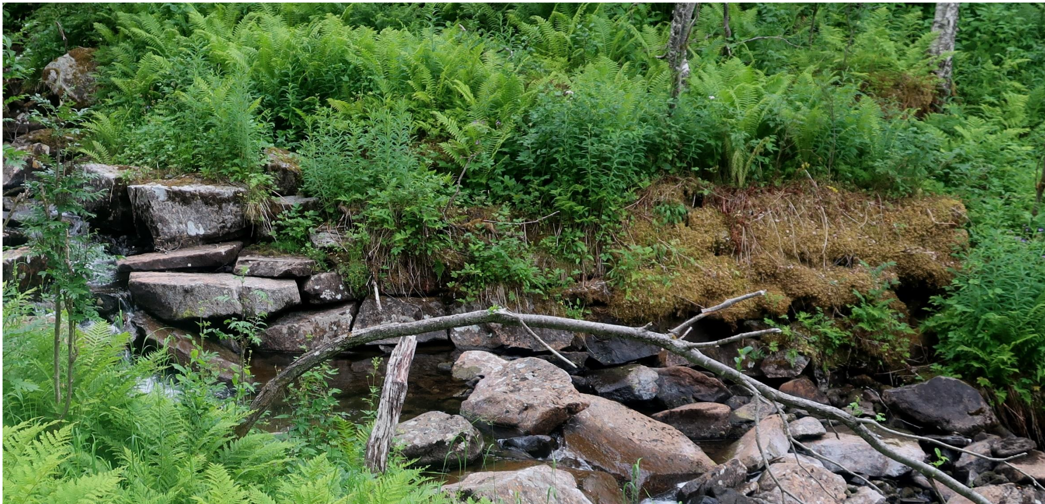
Og her – oppstart bygging av brufundament oppe i Kovandalen. Ei bru det aldri ble noe av.
