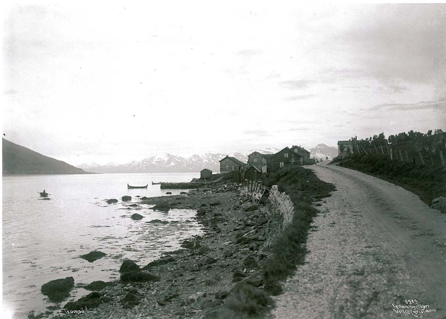
Vegparti ved Tromsøysundet, Tromsø 1907
