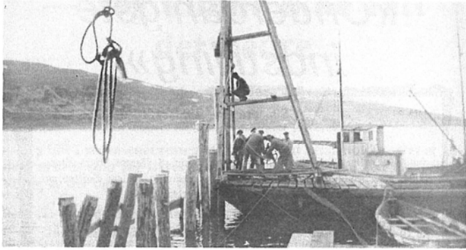
Peling pågår til det første ferjeleie i Kvalsund i ferjesambandet Kvalsund—Stallorgo. Bildet er fra midten av 30-åra.
