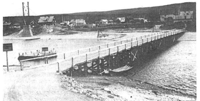
Bygging av Karasjok hengebru i 1942.
