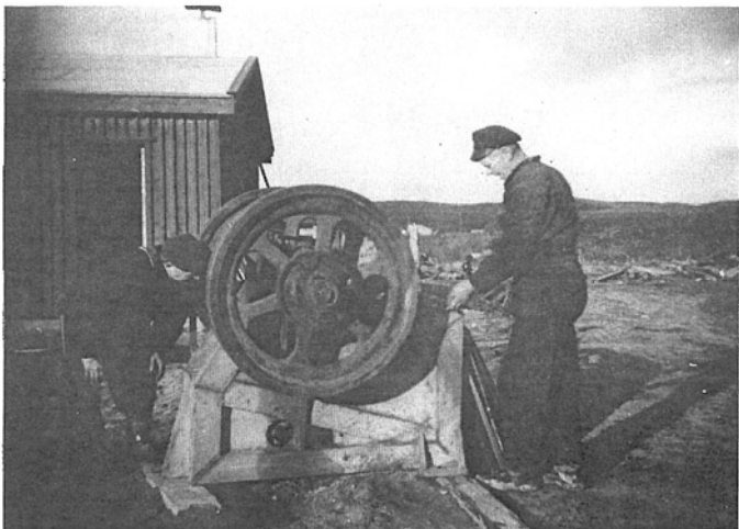
Dravn stenkuser til reparasjon på Skipagurra i 1948. Oppsynsmann Trygve Sagen (t.h.) og smed John Eriksen diskuterer arbeidet.
