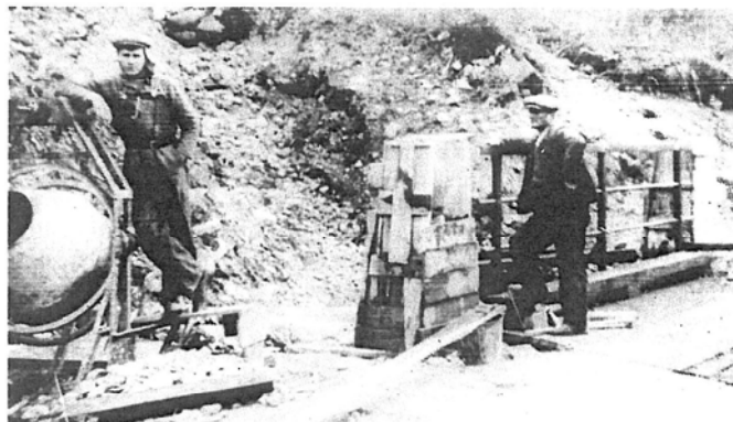
Riksveg 890 Kongsfjorddalen 1937. Oppsynsmann Edvin Eliassen (t.h.) på befaring i forbindelse med bruarbeide. Vedkommende ved blandemaskinen er ukjent.
